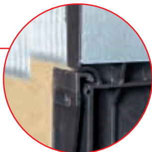
Työnnä levyn yläreuna korvakkeita vastaan
