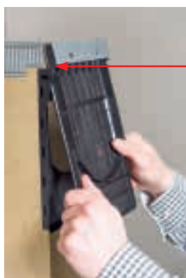
Työnnä levyn yläreuna korvakkeita vastaan
