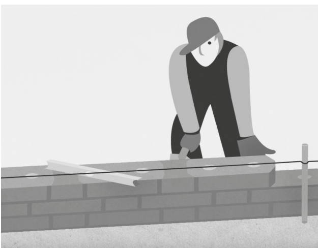
Kuva 6. Kerrokset ladotaan paikoilleen puolen parin limityksellä siten, että pystysuorat reiät tulevat aina kohdakkain.
