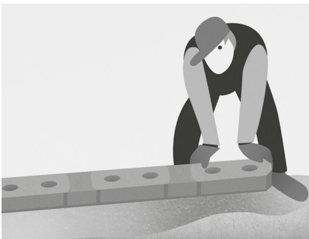
Kuva 5. Ensimmäinen kerros ladotaan asennushiekkan varaan. Pitkä ja lyhyt kivi vuorottelevat.
